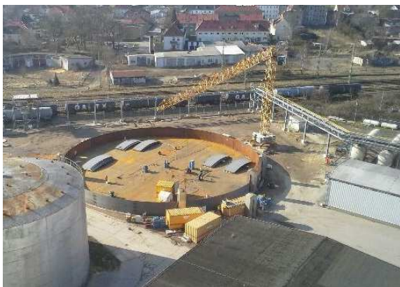
Foto: Baustelle Dicksafttank 4
